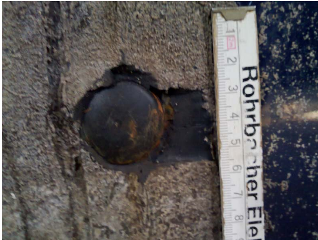
Fehlstelle im Bereich der Schraubenreihen
