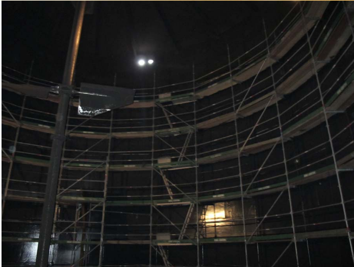
Ansicht während der Sanierung
