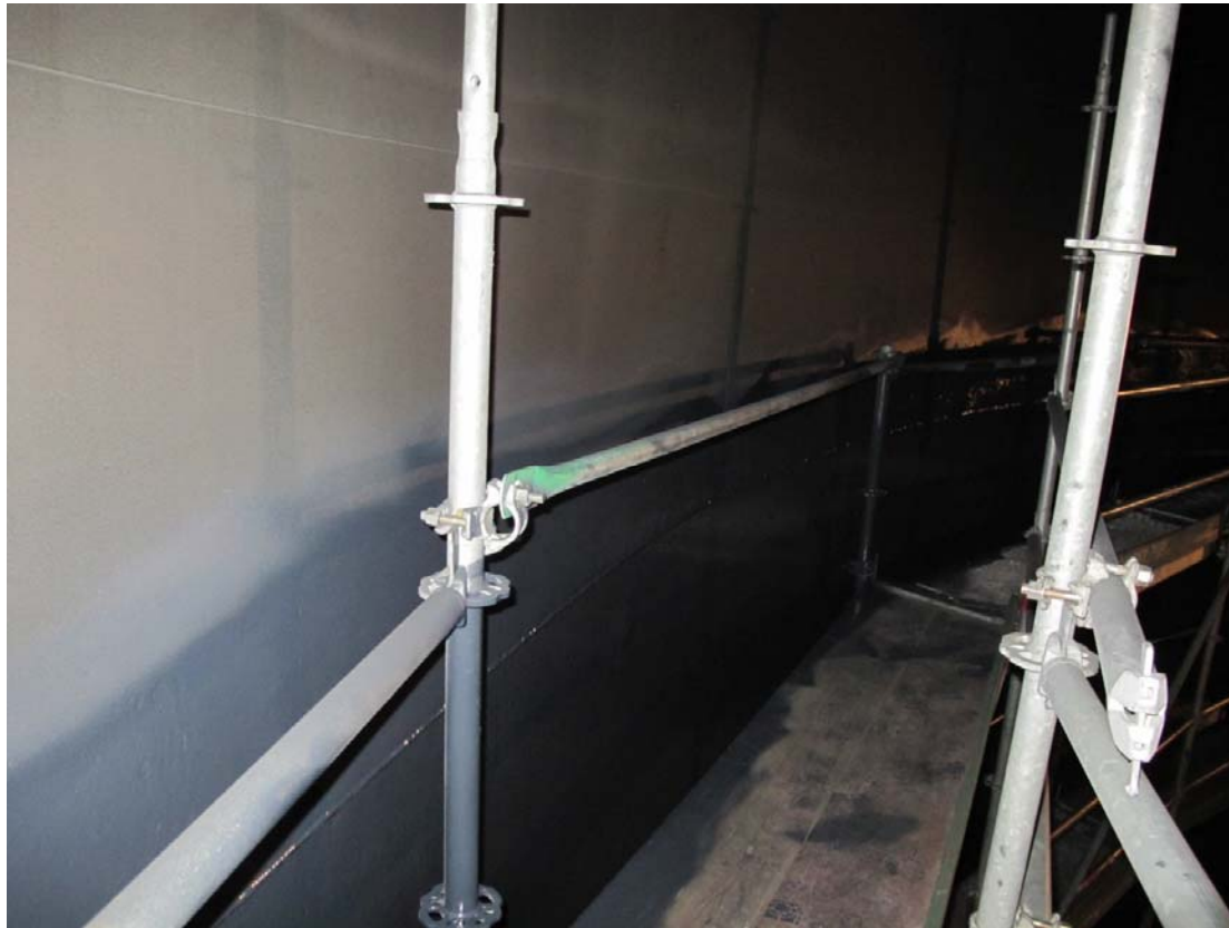
Überlappung mit SikaPoxitar F auf neue Beschichtung
